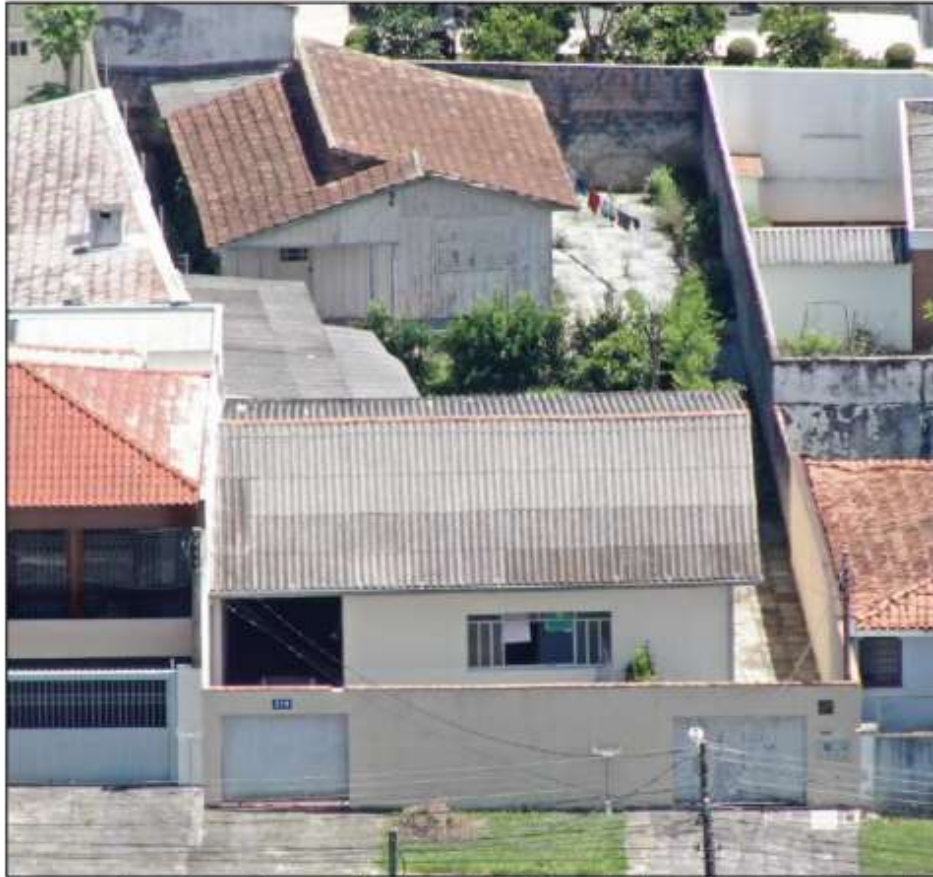
Imagem aérea do endereço situado na Rua Coronel José Ribeiro De Macedo Junior, 219, Jardim Social, Curitiba/PR.
